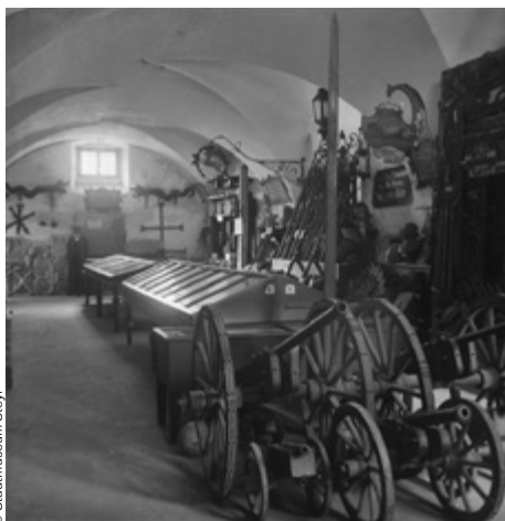
Blick in die Eingangshalle des Innerberger Stadels im Erdgeschoß, ca. 1919
