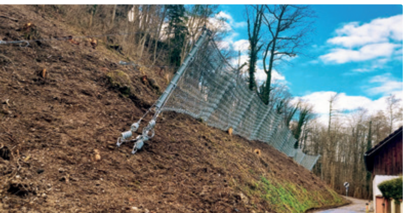
◀ Mit diesem Schutzzaun hat die Wildbach- und Lawinerverbauung das erste Teilprojekt an der Konglomeratwand in Unterhimmel abgeschlossen.
