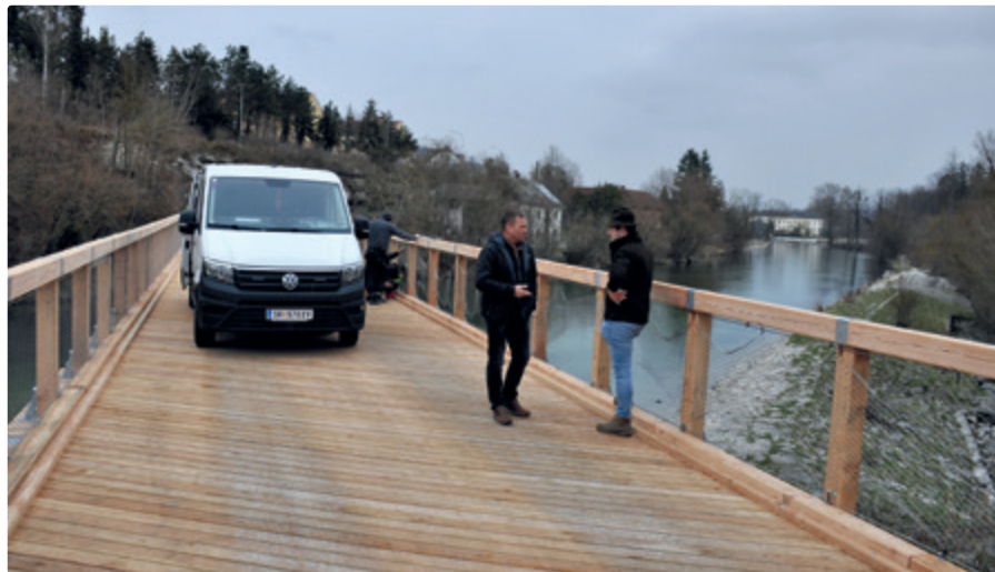
▲ Baureferent Vizebürgermeister Helmut Zöttl (li) verfolgt die letzten Arbeiten an der Brücke und bedankt sich bei den Arbeitern.
